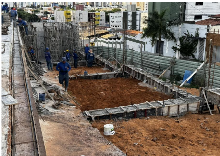
Figura 7. Concretagem das vigas de fundação do “Caixão Perdido”.
