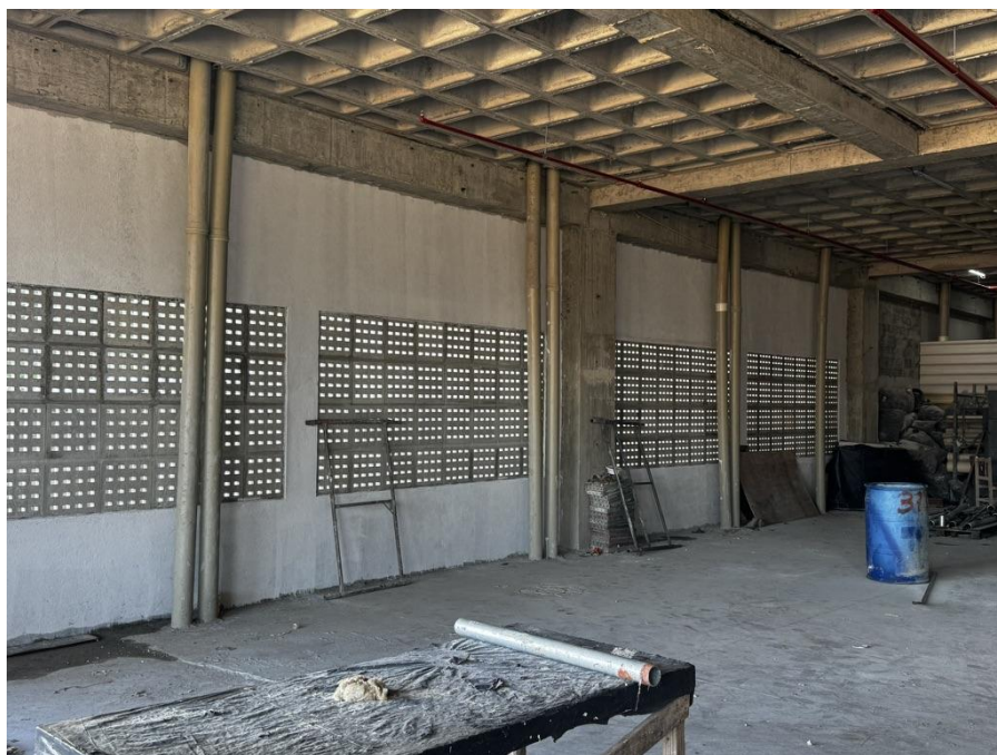
Figura 21. Tubo pvc esgoto ou água pluvial predial dn 100mm, série reforçada.
