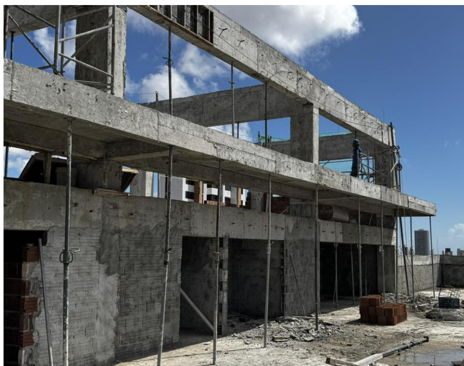
Figura 6. Concretagem dos pilares, vigas e laje dos reservatórios e platibanda da cobertura.
