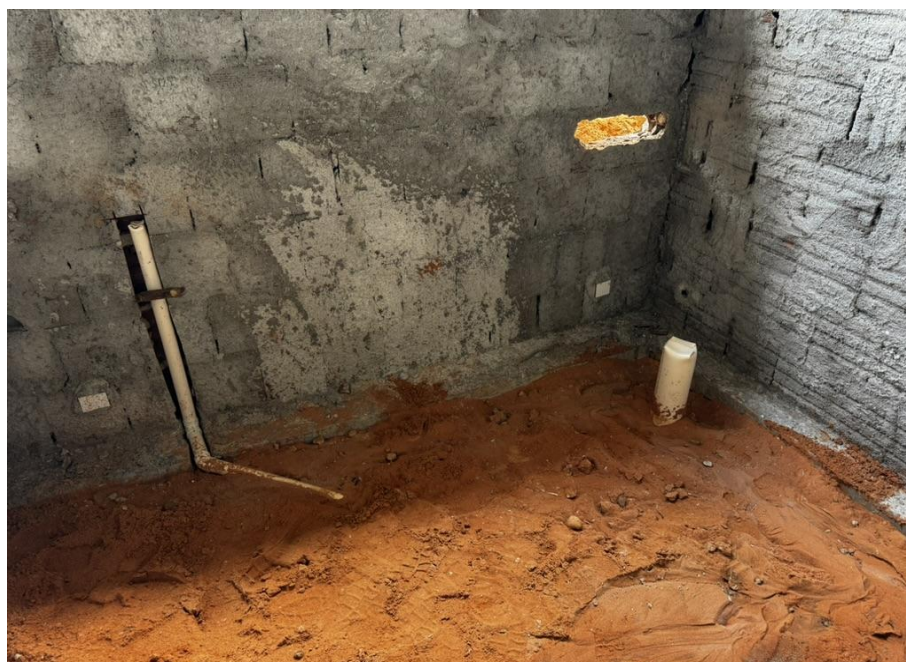
Figura 19. Início da instalação das tubulações de esgoto.
