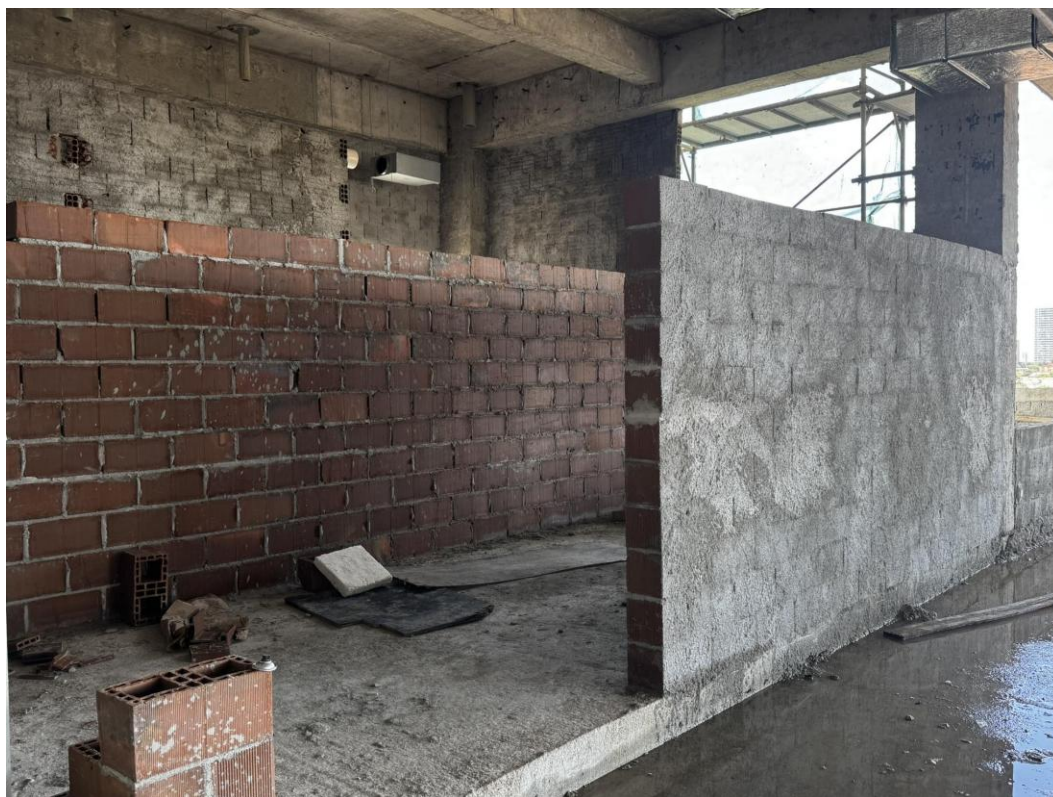
Figura 17. Execução de alvenaria com blocos cerâmicos com 19cm de espessura com aplicação de vermiculita.
