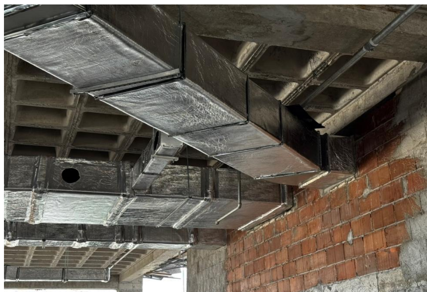
Figura 24. Instalação da tubulação dos dutos de ar-condicionado galvanizados já com o isolamento.
