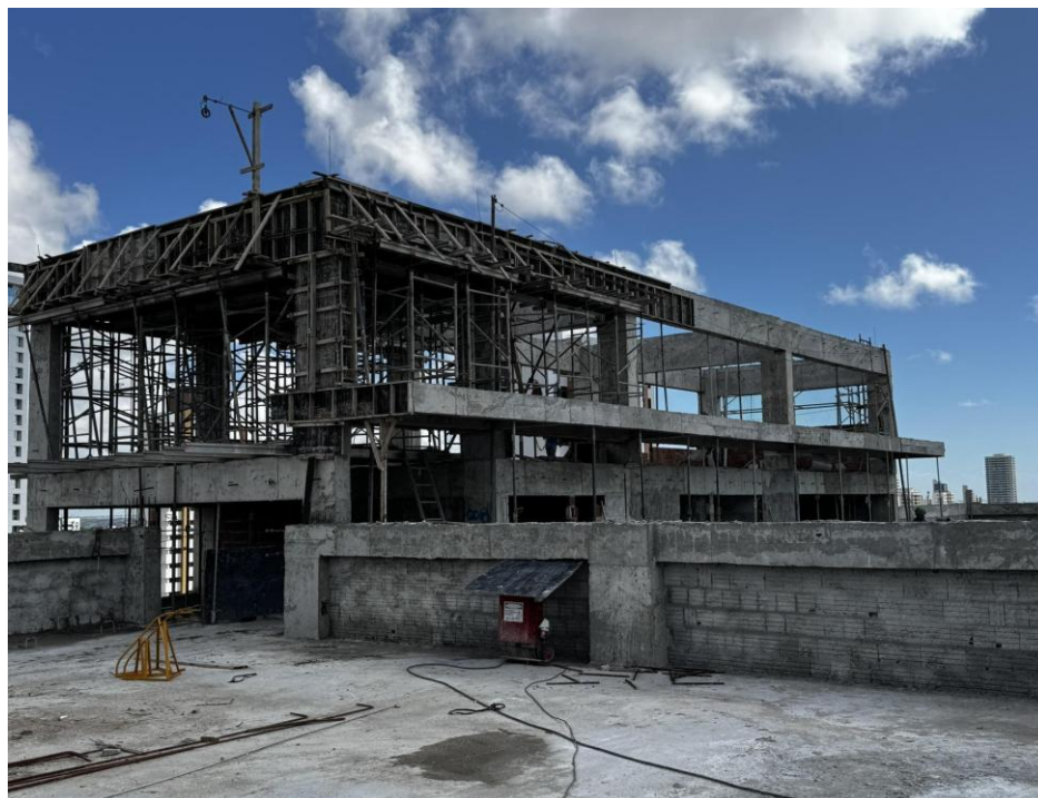
Figura 5. Concretagem dos pilares, vigas e laje dos reservatórios e platibanda da cobertura.
