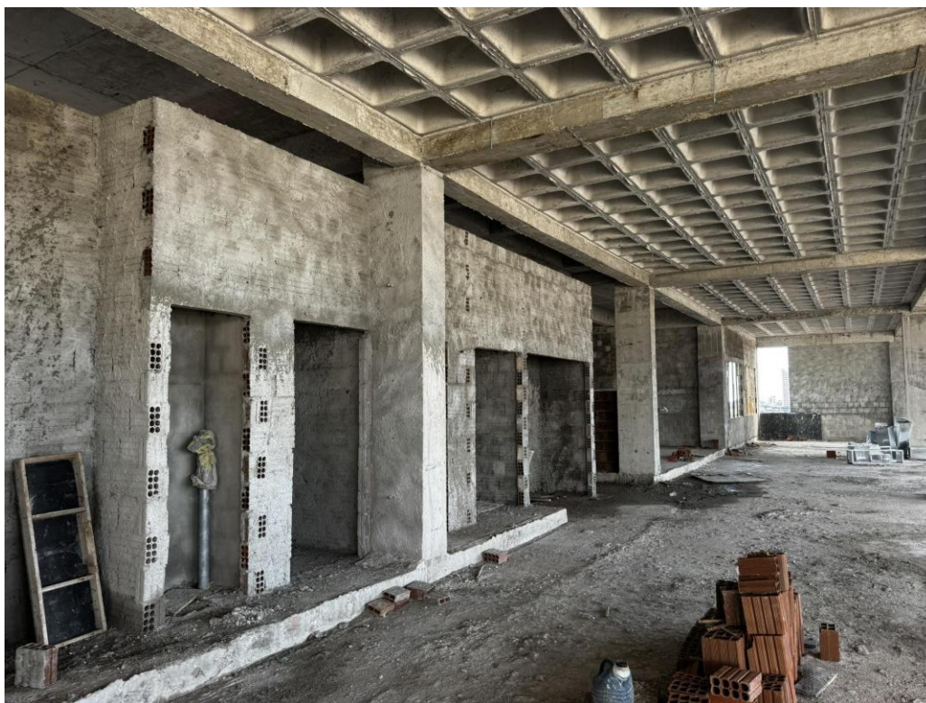
Figura 11. Execução de alvenarias com tijolos de 9cm de espessura nos banheiros do pavimento térreo.
