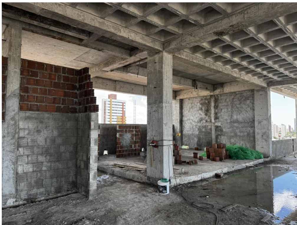
Figura 12. Execução de alvenaria de 9cm nas paredes dos banheiros no segundo pavimento.
