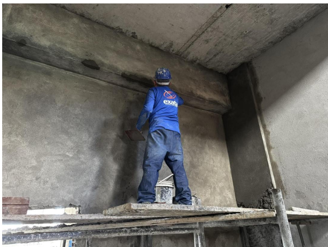
Figura 16. Aplicação de massa única nas paredes internas.
