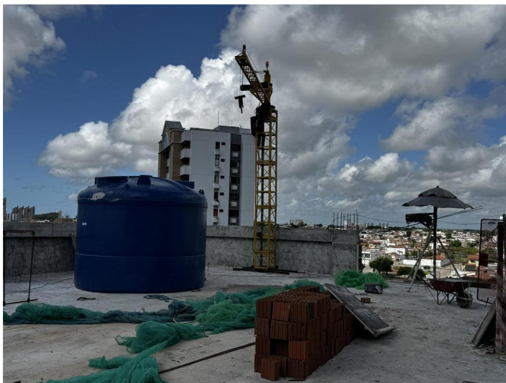
Figura 3. Utilização da torre grua para a subida dos reservatórios de água da cobertura.
