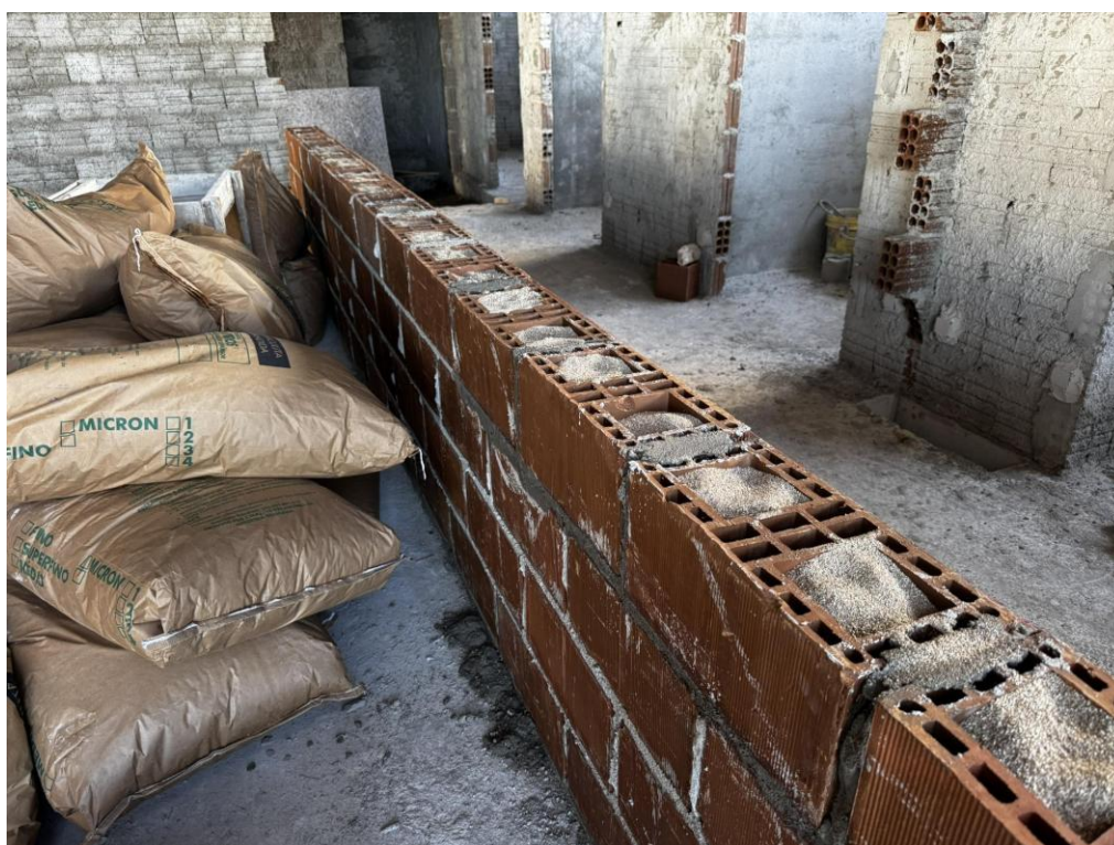
Figura 18. Execução de alvenaria com blocos cerâmicos com 19cm de espessura com aplicação de vermiculita.
