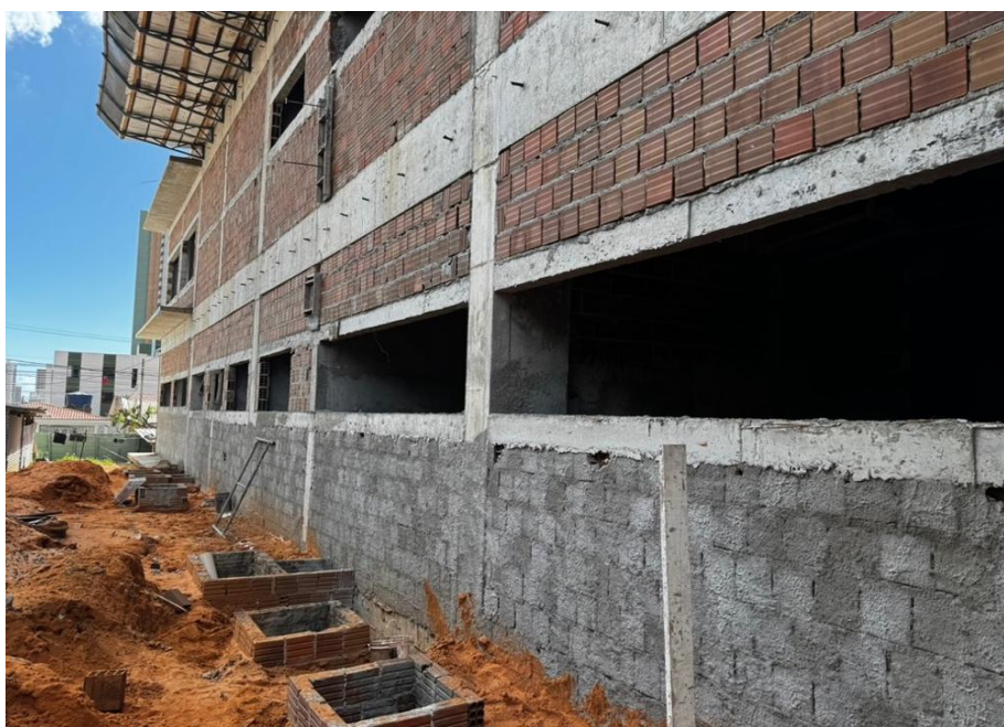
Figura 20. Execução das caixas de passagem em alvenaria.
