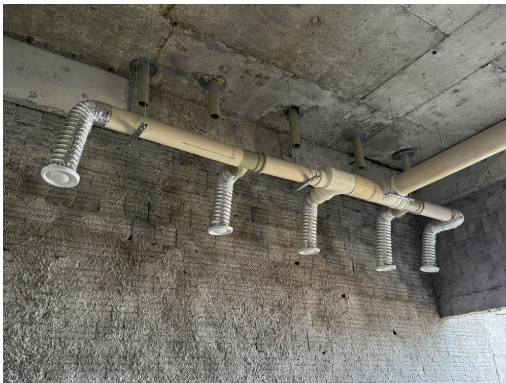
Figura 27. Instalação do sistema de exaustão com tubos de PVC.
