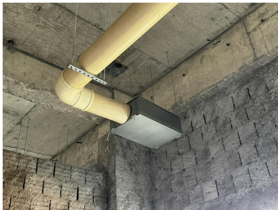
Figura 26. Instalação de Exaustor, item 15.1.2 da planilha.
