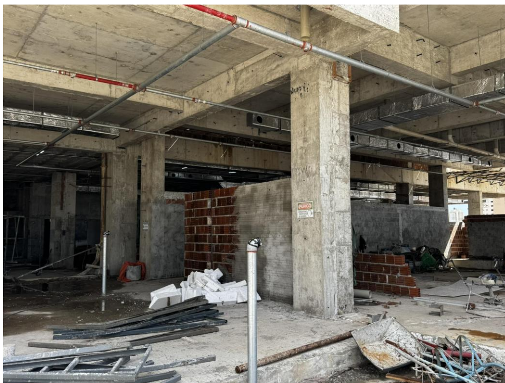
Figura 13. Execução de alvenaria 14cm no perímetro do auditório no pavimento térreo.
