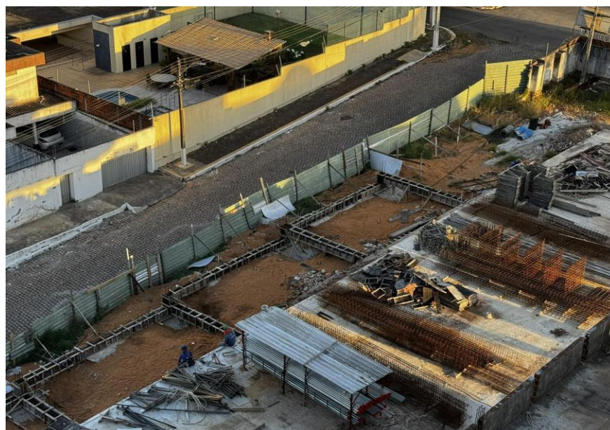
Figura 8. Local onde será executado o “Caixão Perdido”.
