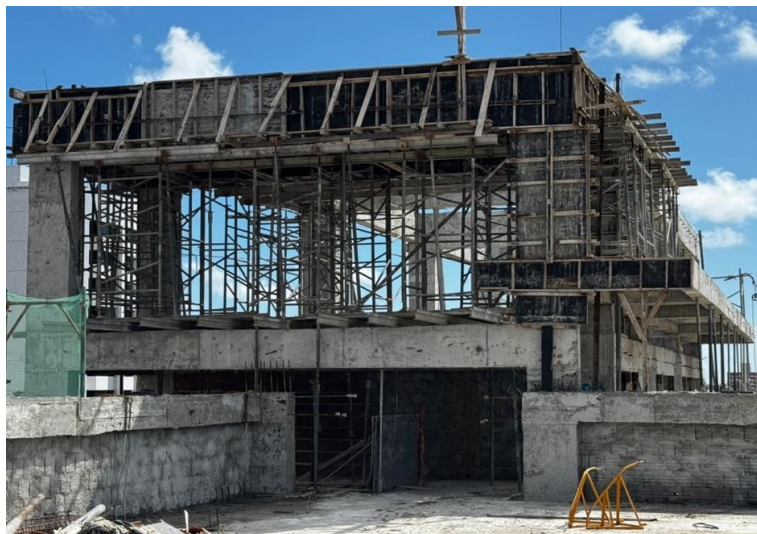
Figura 23. Instalação da última camada das hastes de aterramento na laje de cobertura acima da caixa da escada.
