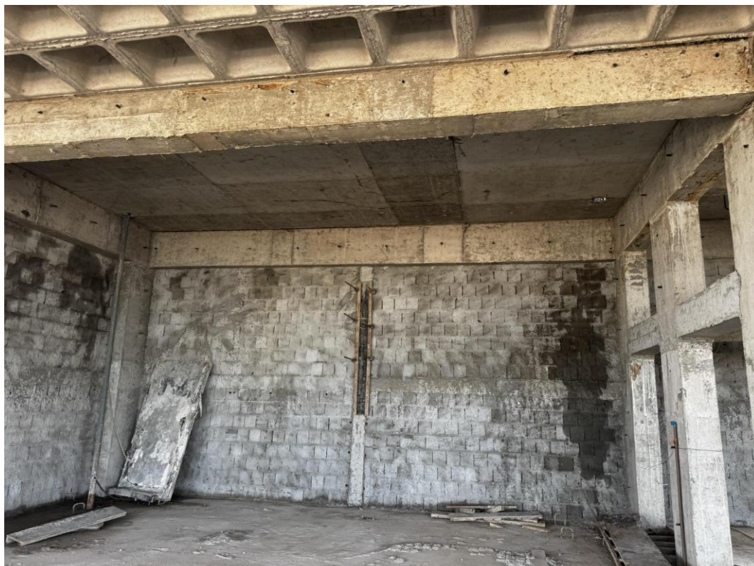
Figura 15. Chapisco aplicado nas paredes internas.
