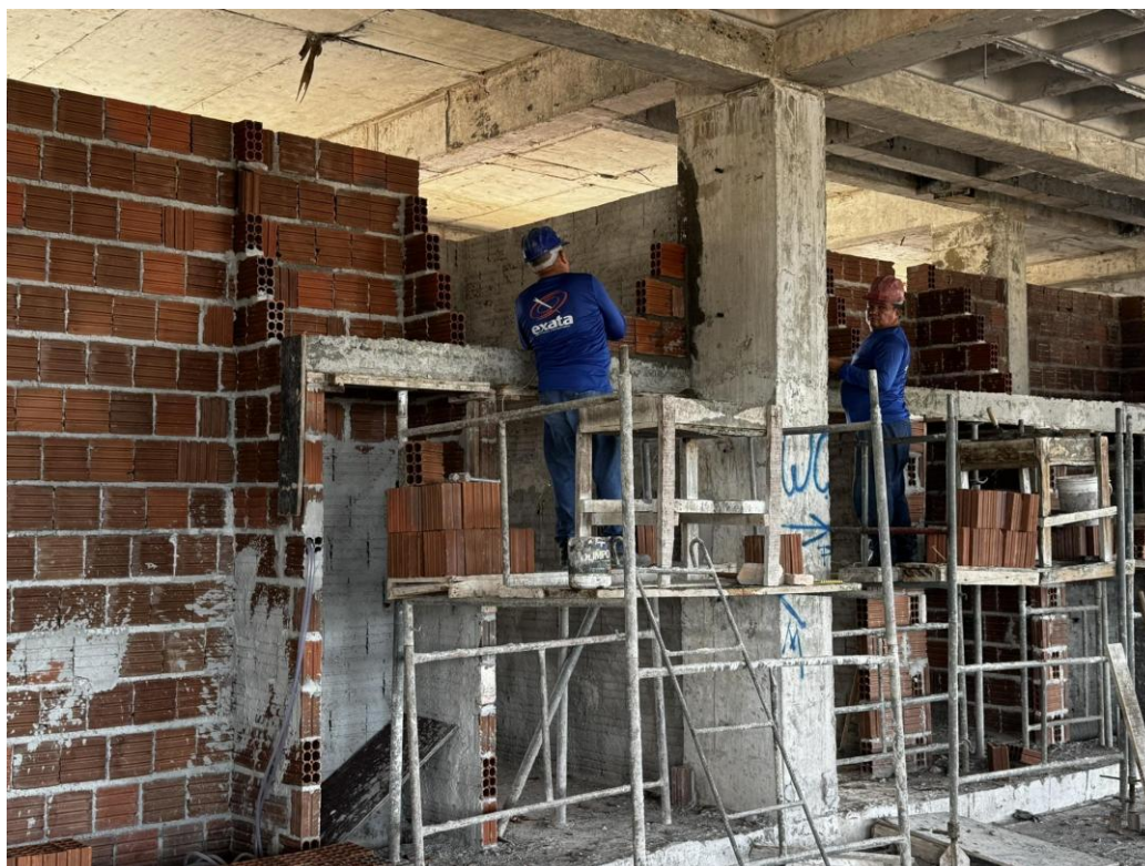
Figura 4. Andaimos para elevação das alvenarias no pavimento térreo.
