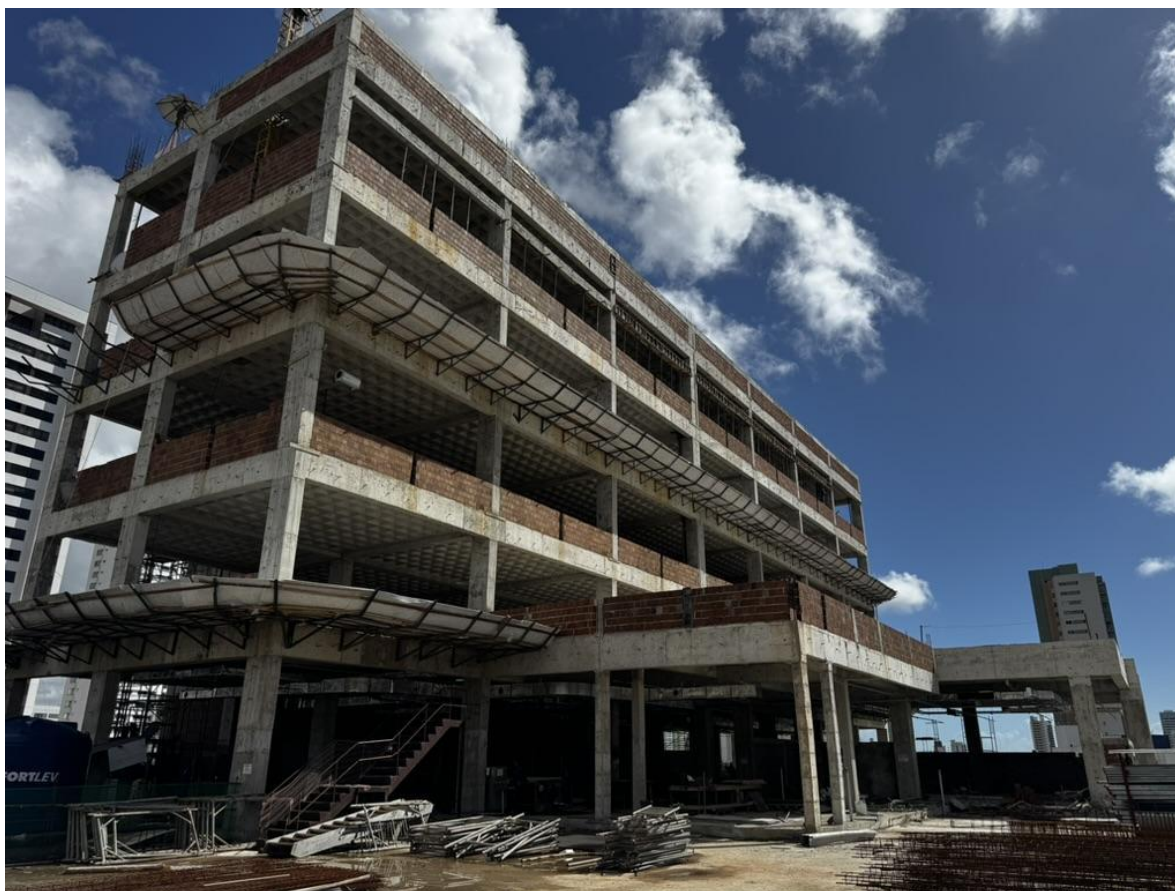
Figura 1. Visão geral da obra.
